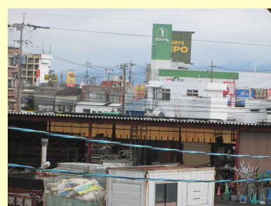
倉庫屋根への太陽光パネル設置
